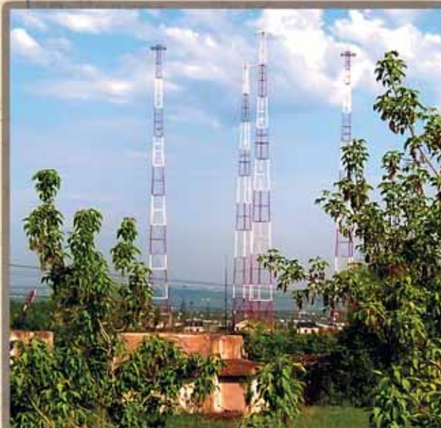
Вид на крышу технического здания. Вдали — комплекс передающих антенн средневолнового диапазона.
